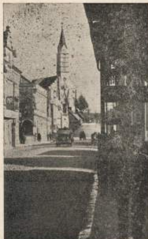
A Matriz que já foi demolida
